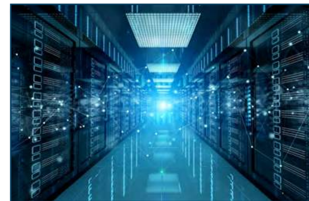
Controle Remoto de todos os Nobreaks do TRT da 18ª Região
